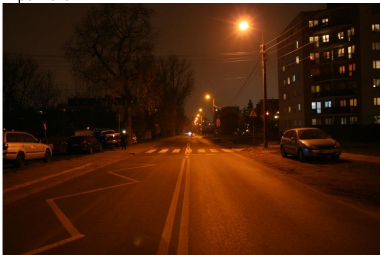
Rys. 9.13 Widok instalacji oświetleniowej – przypadek 1
